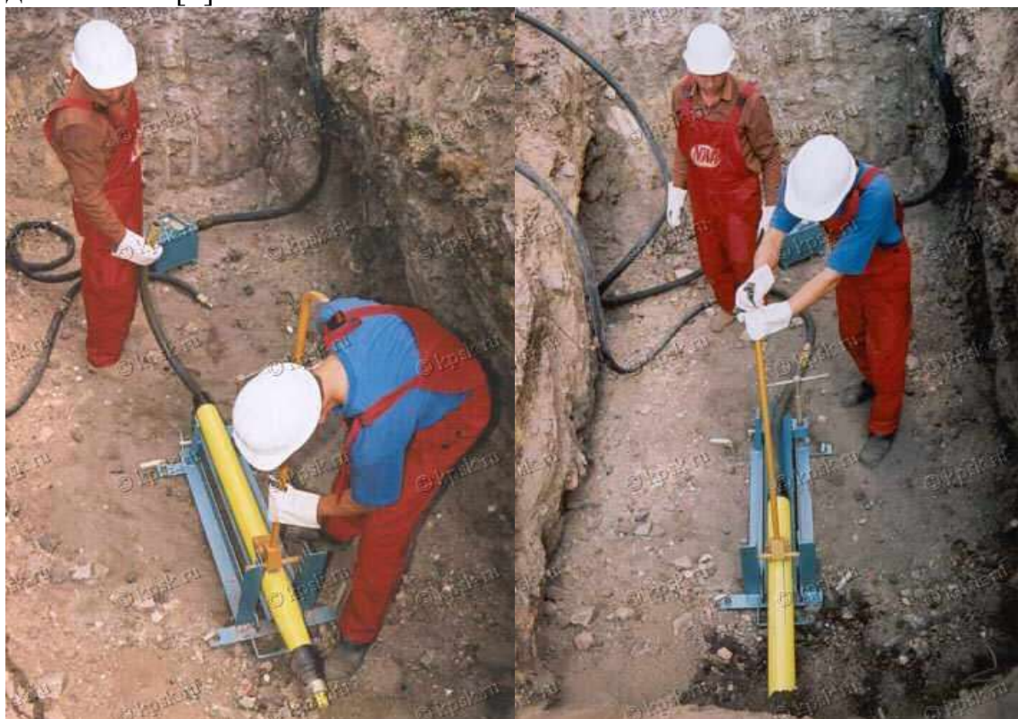
Рис. 1.2. Фотографии подготовки пневмопробойника ИП 4605А к выполнению работ по устройству выштампованной микросваи
