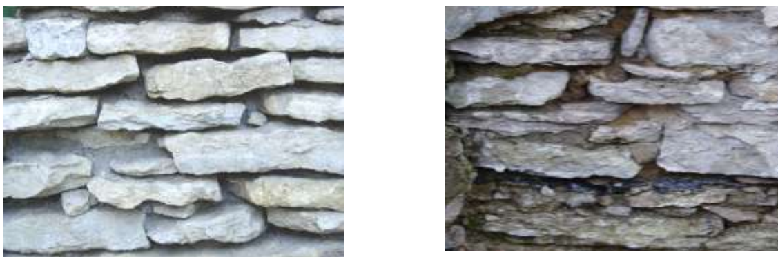
Рис. 1.2. Фотографии внешней стороны кладки бутовых фундаментов со следами физического износа и снижением прочностных свойств.
