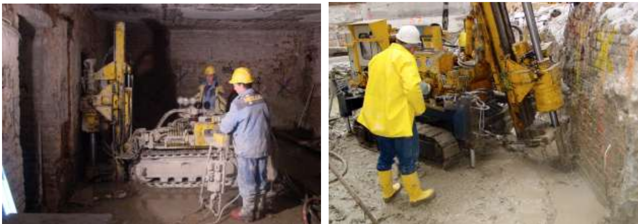
Рис. 3.8. Фотографии малогабаритной строительной техники, используемой при усилении оснований реконструируемых зданий.
