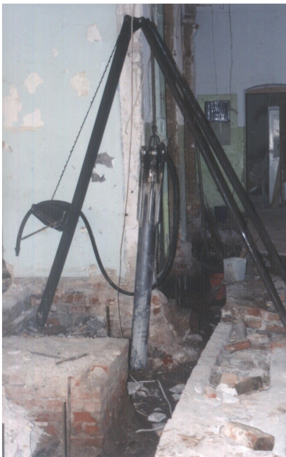
Рис.1.2. Фотография производства работ по использованию пробойника при выполнении выштампованных микросвай усиления основания
