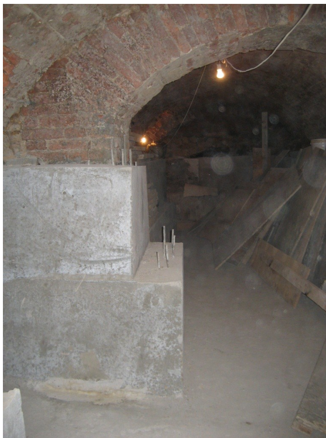
Рис. 3.6. Фотография внутренней кирпичной стены подвала здания после реконструктивных работ по углублению подвала с устройством железобетонной вертикальной прижимной стенки (см. расчётную схему на рис. 3.4). Выполнение подобного вида работ успешно осуществляется ООО СК «Подземстройреконструкция» ( http://www.sk-psr.ru )
