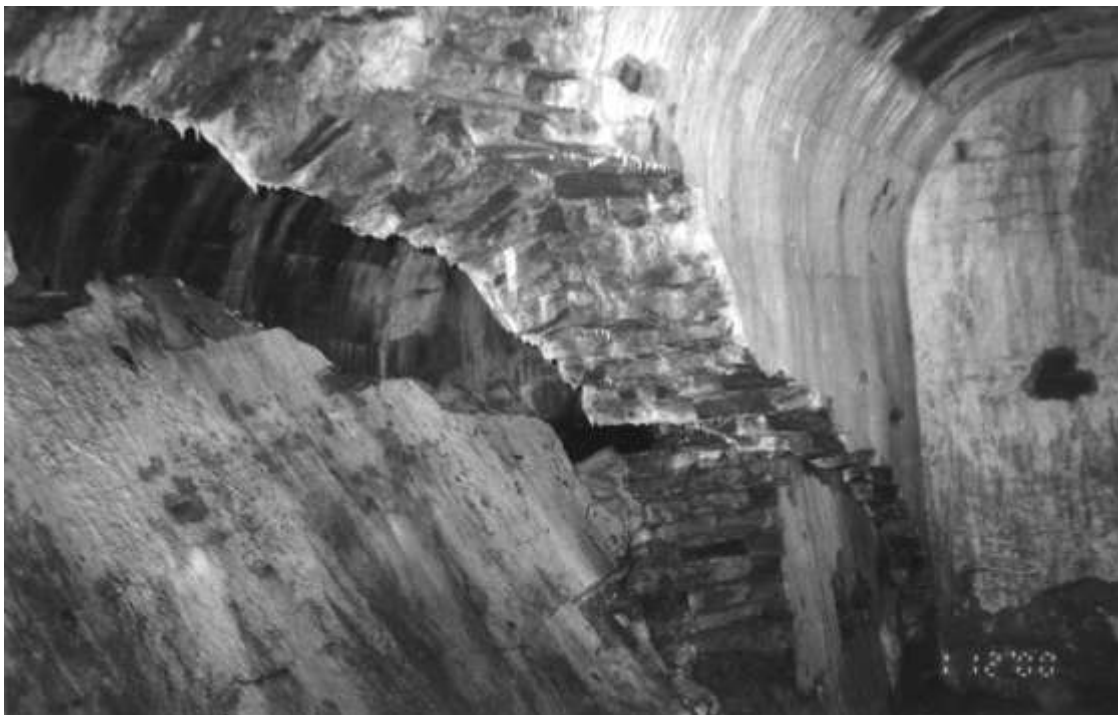
Рис. 1.10. Потеря устойчивости поперечной стены погребца
