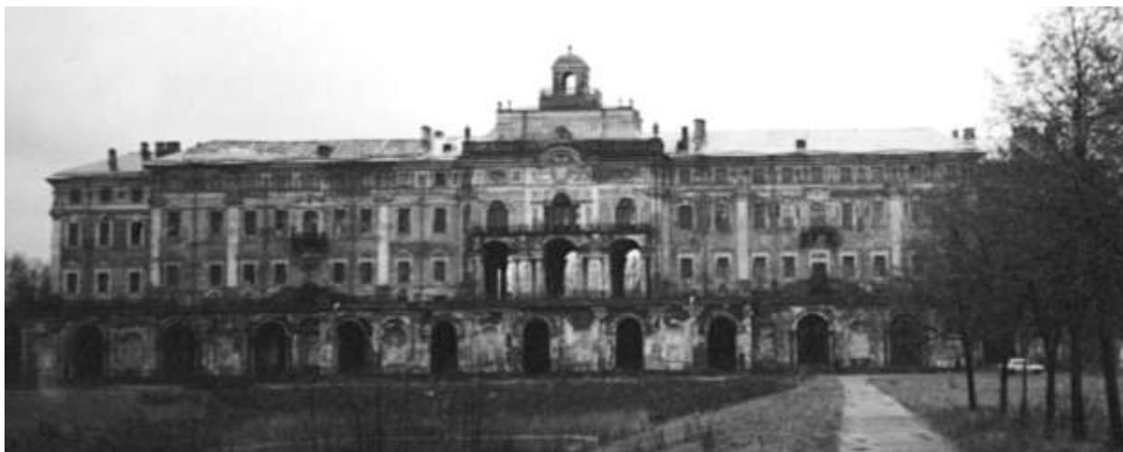
Рис. 1.8. Состояние Константиновского дворца до реконструкции
