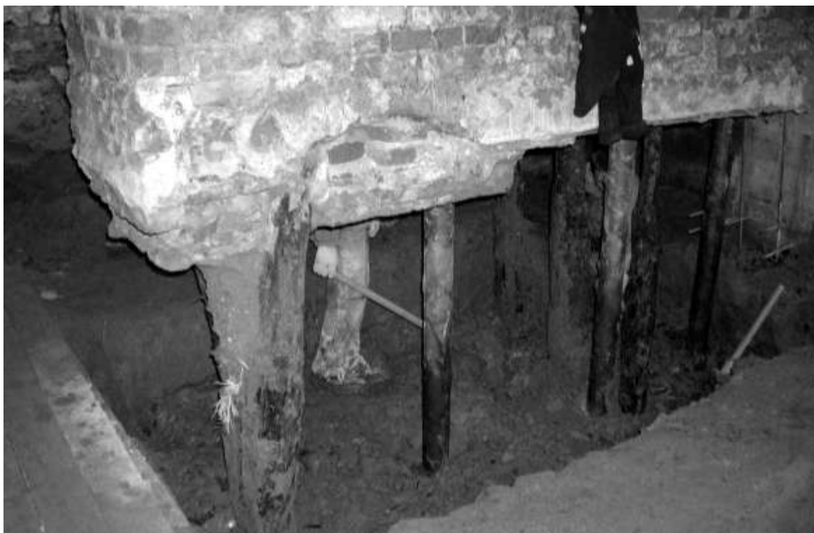
Рис.1.14. Углубление уровня пола в погребках террасы дворца. Стены вывешены на буроинъекционных сваях усиления
