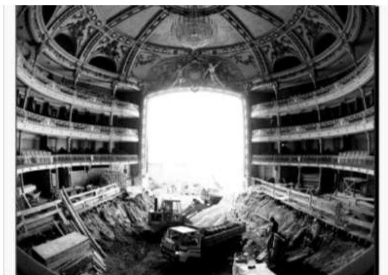
Рис. 1.2. Начальные работы по откопке котлована в центральной части театра
